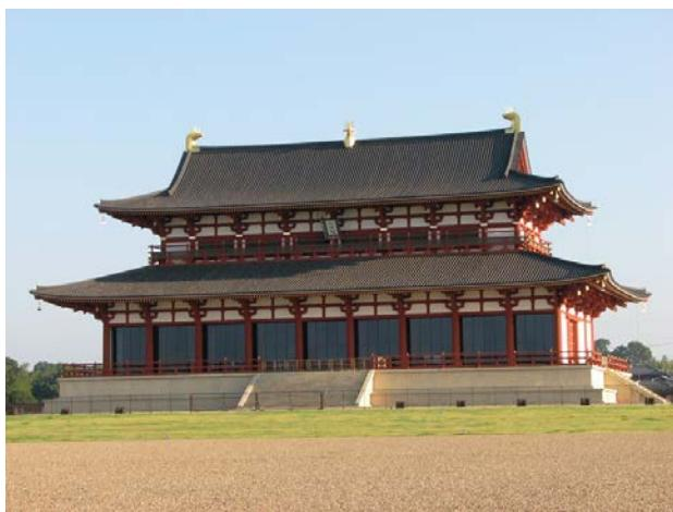
大極殿は、間口44m、高さ24m（大仏殿は49m）の巨大建造物であるが、免震構造の土台の上に基壇を作り、阪神淡路大震災級の地震にも充分耐えられるそうである。遷都1300年祭のシンボルとして、約190億円を投じて復元された。
